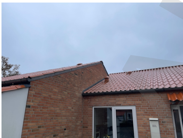
Inddækning ved tagspring
